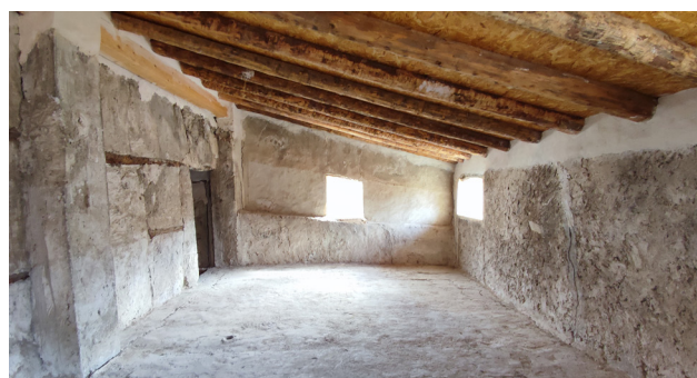
Figura 2. Resultado de la Intervención en las cubiertas de 2024.
