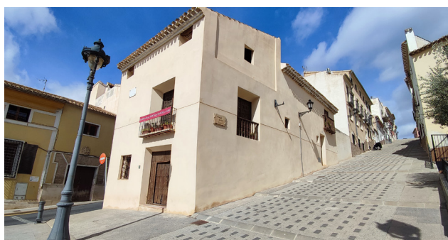
Figura 3. Estado actual del exterior del edificio.
