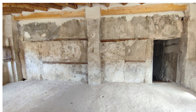
Figura 9. Ático en la planta segunda con trabas de madera vistas.
