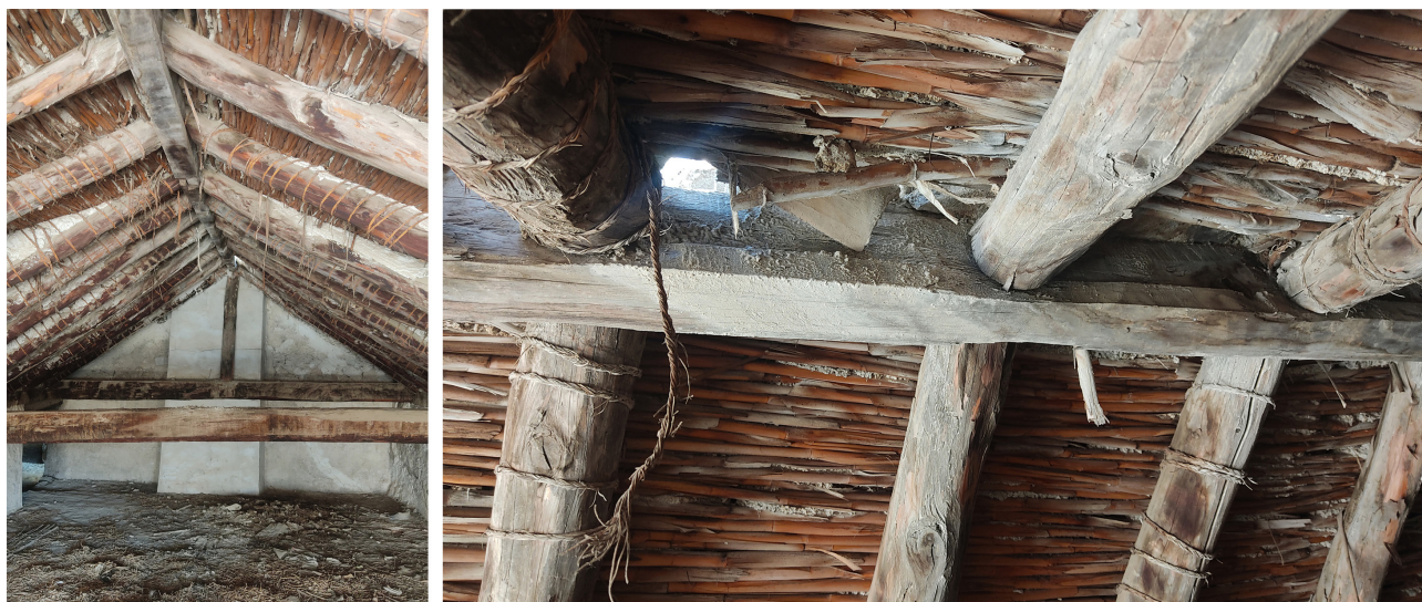
Figura 6. Cubierta de la crujía sureste. Izquierda: vista general. Derecha: detalle. (Autor).
