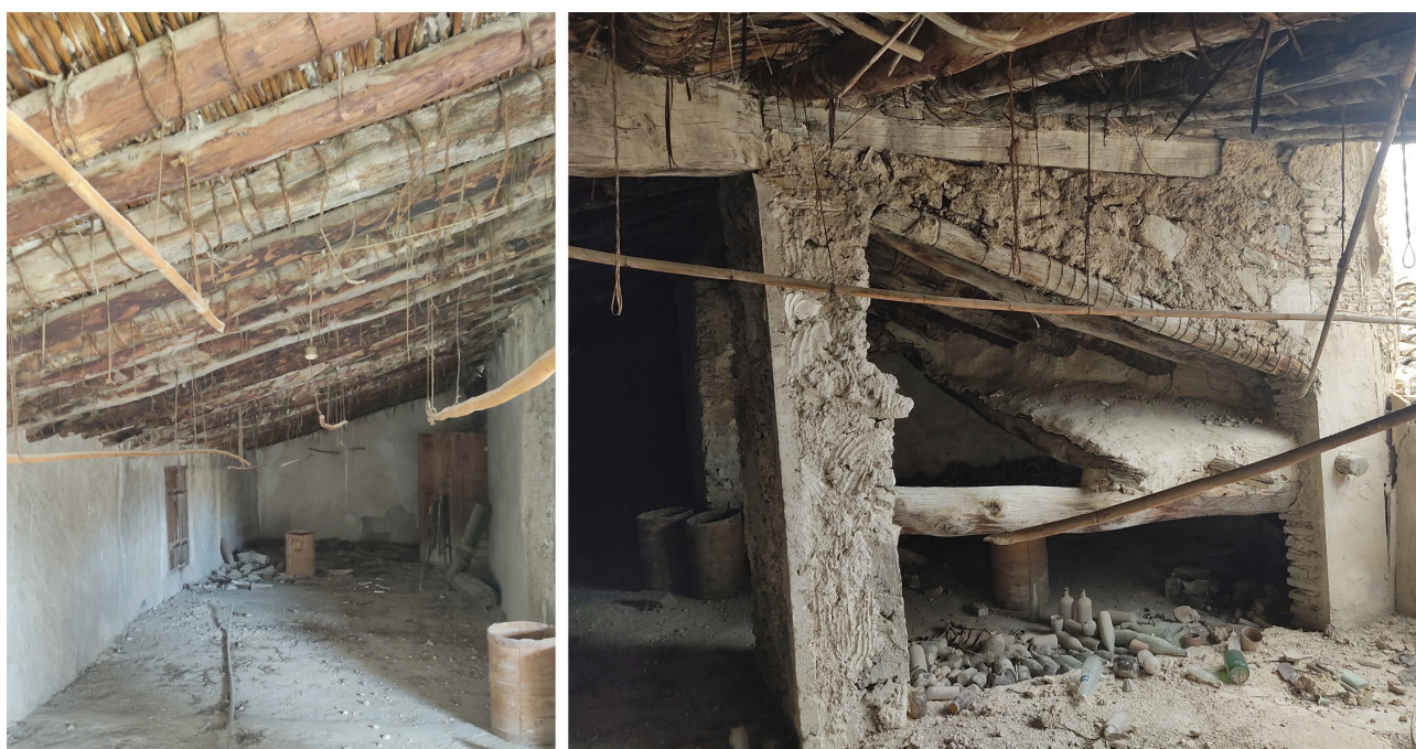
Figura 7. Cubierta del volumen edificado después del siglo XVIII. Izquierda: faldón recayente a calle Mayor de Arriba (7a). Derecha: a calle Alonso de Góngora (7b). Autor.
