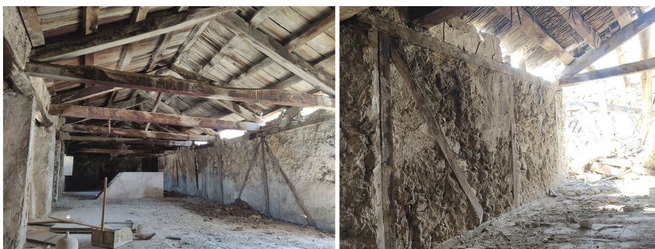
Figura 5. Izquierda: cubierta de la crujía noroeste. Derecha: cubierta de la crujía suroeste. (Autor).
