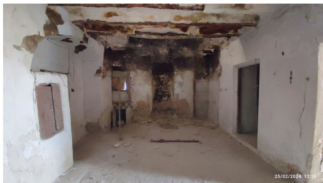
Figura 5. Estancia de la chimenea en la planta baja.
