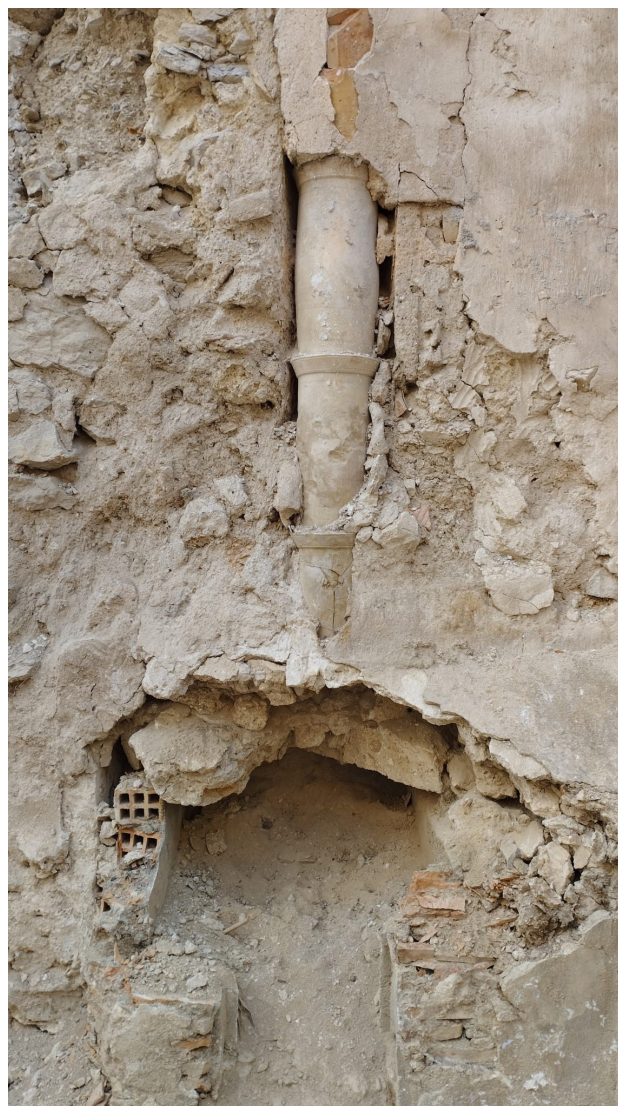
Figura 12. Canalización cerámica s. XVIII.
