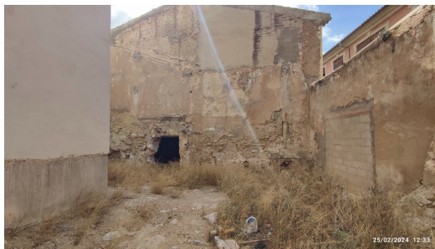
Figura 7. Vista del estado del patio previo a la intervención.
