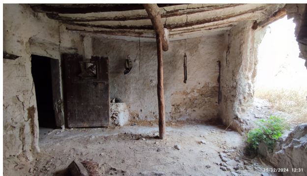
Figura 6. Establo o cuadra en la planta baja.
