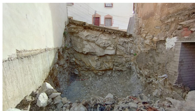
Figura 15. Excavación sobre niveles geológicos (margas sedimentarias) para hueco de ascensor.
